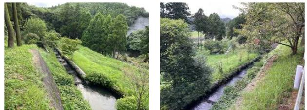
ジグザグに人工的な川の流れを作ることによって、生き物たちが自由に移動できるようになっています。「こせの滝魚道」は、「ボックス型魚道」と呼ばれる施設があり、高低差7mを克服するために大変な工夫がなされています。
