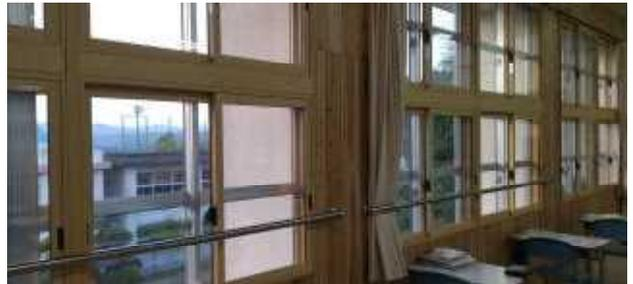
3年1組教室の断熱改修工事の最終仕上げである二重窓の設置が完了しました。現在1年生の有志が教室内の室温の経過調査を行っており、実証実験のデータ検証を行っています。夏涼しく、冬暖かい環境が実現でき、電気代節約など環境に優しい環境作りへの挑戦が実を結ぶ日も近いと期待しています。
